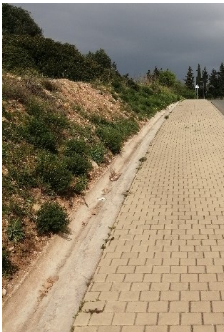
Figura 14. Aspecto das escavações e valas de drenagem
